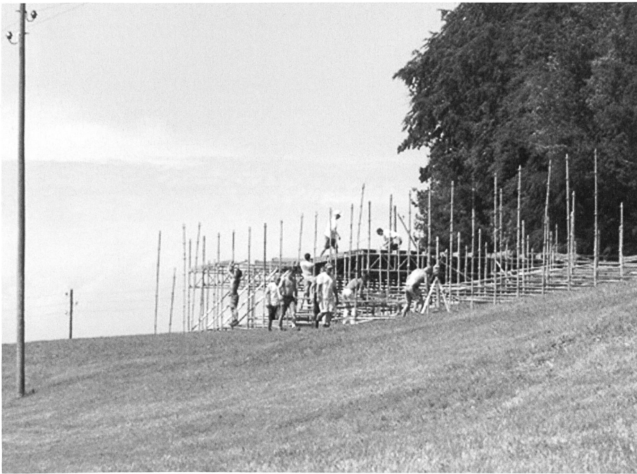
Beim Bau des SVP-Tempels in Tufertschwil
