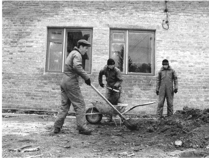
Toilettenbau für Waisenhaus
