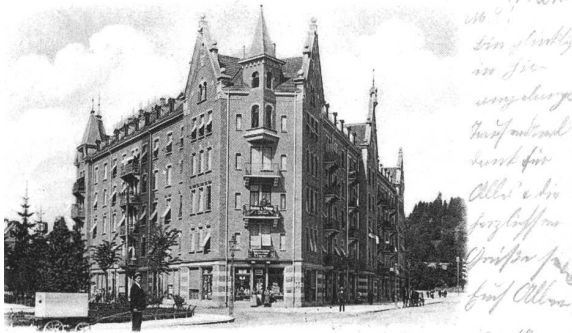
St. Gallen - Neue St. Leonhardsstr. u. Büchelstr.
