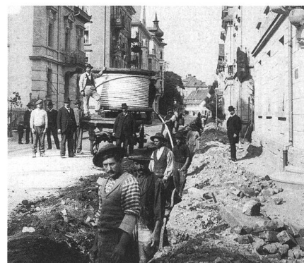
Italienische Gastarbeiter bei der Kabelverlegung in Rorschach (1912)
