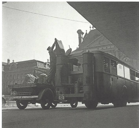
Brennstoff nachfüllen: Es braucht eine Menge Holz oder Tannenzapfen, um mit dem Bus einigermaßen vorwärts zu kommen.
