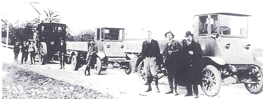
Elektrische Tribelhorn-Lastwagen, die 1919 von den Berner Kraftwerken beim Bau des Staudamms Mühleberg verwendet wurden.
