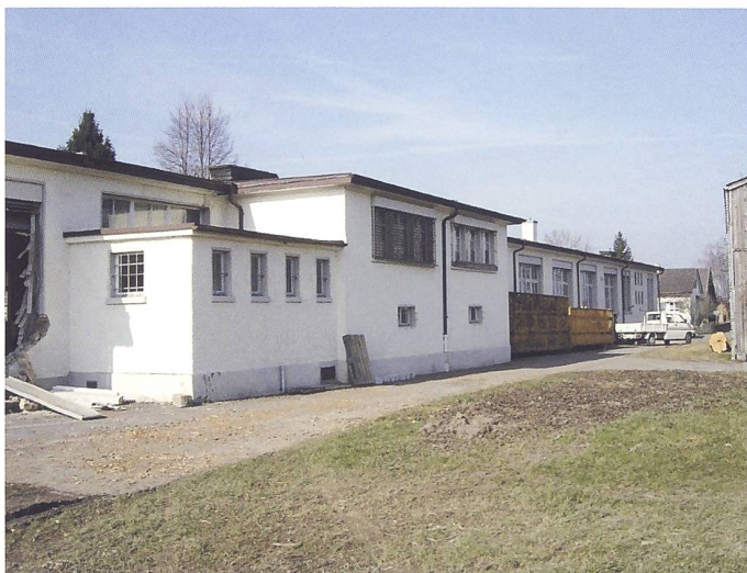
2009, kurz vor dem Abbruch der über 100 jährigen Firma Bickel.
