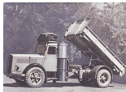
SAURER- Dreiseitenkipper, für Holzgasbetrieb, Typ 5 CT1D, Chassis-Nr: 20342/745 mit kompletter Holzgas-Generatoranlage «Imbert» Nr. 264. Die Auslieferung erfolgte durch Saurer-Monteur Gloor am 16. Mai 1941.
