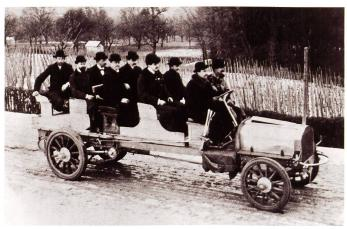
Der erste Saurer OLW 3TK Chassisnr. 2615/1 mit AM II-Motor Nr. 1452 für Motor Car Emporium (MCE) in London (GB) auf Probefahrt. Dieses Omnibus-Chassis wurde auch als «Char à banc» bezeichnet und war der Urahne aller späteren Saurer-Omnibusse!
