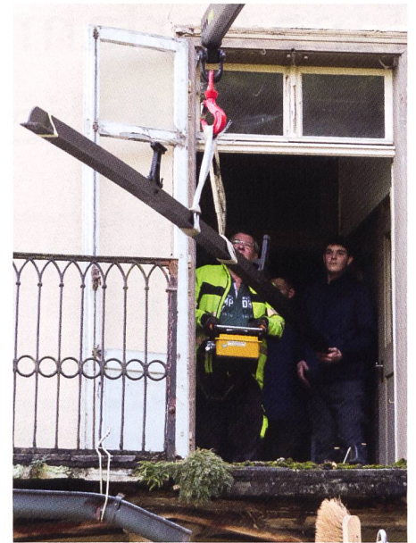
Der Stickwagen wird aus dem 1.Stock gehoben. Zentimeter genau steuert Ruedi Gantenbein seinen langen Kranarm an den Fensterrahmen vorbei.
