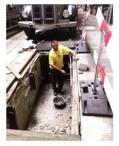
Oliver in der Grube, am fachgemässen Flicken der Stützmauern.
