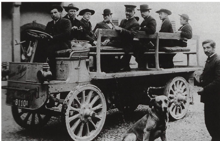
Ein Unterflur-Dufour-Ballabey aus Nyon
