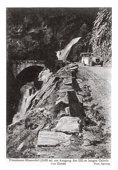
Um zu vermeiden, dass die damaligen Stützmauern aus Trockenmauerwerk auf schlechten Grund infolge des höheren Gewichtes der Wagen einbrechen könnten wurde das Motorfahrzeuggesetz durch die Tafel «Postautos kreuzen bergseits» erweitert (was wohl manch ein- und ausländischen PW-Fahrern das Fürchten und Zittern gelehrt hatte). Diese Verordnung bestand bis in die 50er-Jahre. Bei der Vergabung des Auftrages
