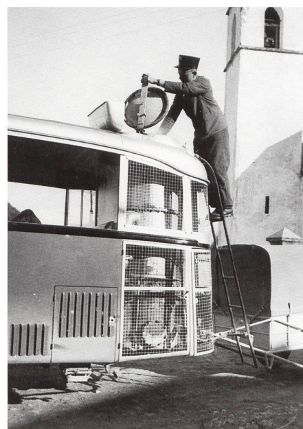
Fütterung des Generators mit Holz am Ofenbergpass / März 1942
