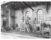
Motorenprüfstand MAN 1893: Erster Dieselmotor auf dem Prüfstand in Augsburg
