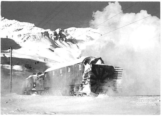
Wohl die mächtigste Schleuder, jedoch auf Schienen: Die Dampfschneeschleuder, gestossen von einer Diesel-Elektrischen Lok auf der Bernina-Strecke
