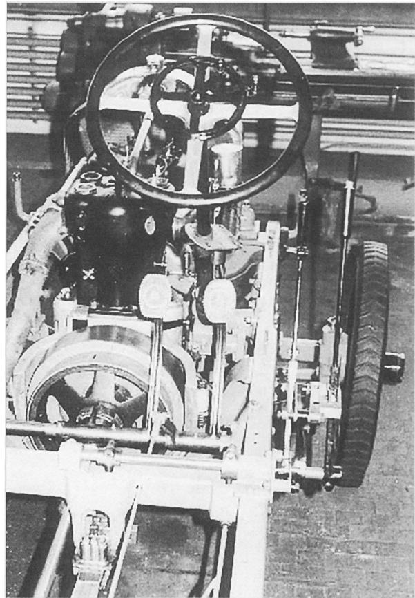
Am kleinen Rad in der Mitte des Steuerrades, sind als Bedienungs-Hebel Zündverstellung und Handgas.
