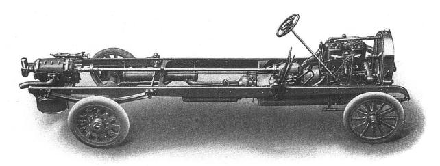
Feuerspritzen-Chassis mit Rundlaufpumpe (Pumpe System Klinger)
