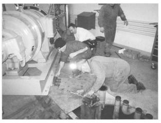
Die Notstromanlage wird mit einem hydraulischen Heber auf Rollen der Fa. Emil Egger gehoben und wir können sie in Richtung Türe schieben. Über den kleinen Absatz an der Türe geht es spielend und bald steht die ganze Anlage im Hof des Kraftwerkes. Den Platz haben wir vorgängig mit einem Schaber von Schnee und Eis befreit. (Im Glarnerland hat es über Weihnachten ca. 60 cm Schnee gegeben).
