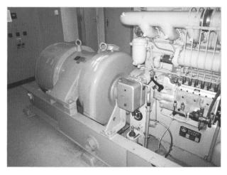
Hinter einer unscheinbaren Doppeltür zeigt uns Walter Giger von der Axpo die Notstromanlage mit dem Saurer Dieselmotor Typ BXDSL und dem Still Generator. Alles ist noch komplett montiert, also Nova Kompressor, Druckluftbehälter, Dieseltank und Wasserkühlanlage.
