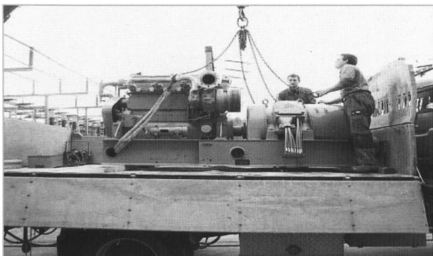
Nach ca. 2 Stunden ist die Einheit Dieselmotor und Generator sicher auf dem Lastwagen abgesetzt.
