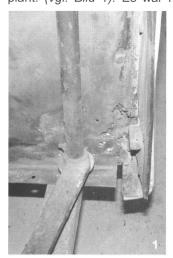
So schlimm sieht es aus! Total verrostet und korrodierter Winkel bei der Türe
