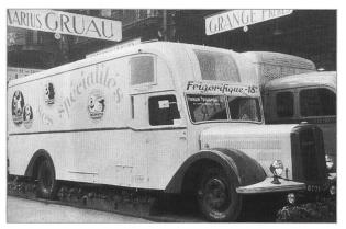
Kühlaufbau von David auf 3CT1D. Das Kühlaggregat ist oberhalb des Fahrerhauses in den Aufbau integriert
