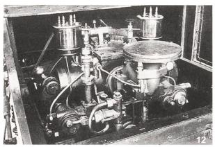
Im Fahrzeug von 1898 eingebauter Motor des Types B II
