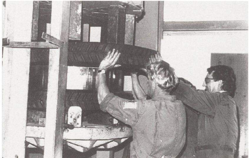
Der Vollgummireifen wird in der Presse aufgelegt.
