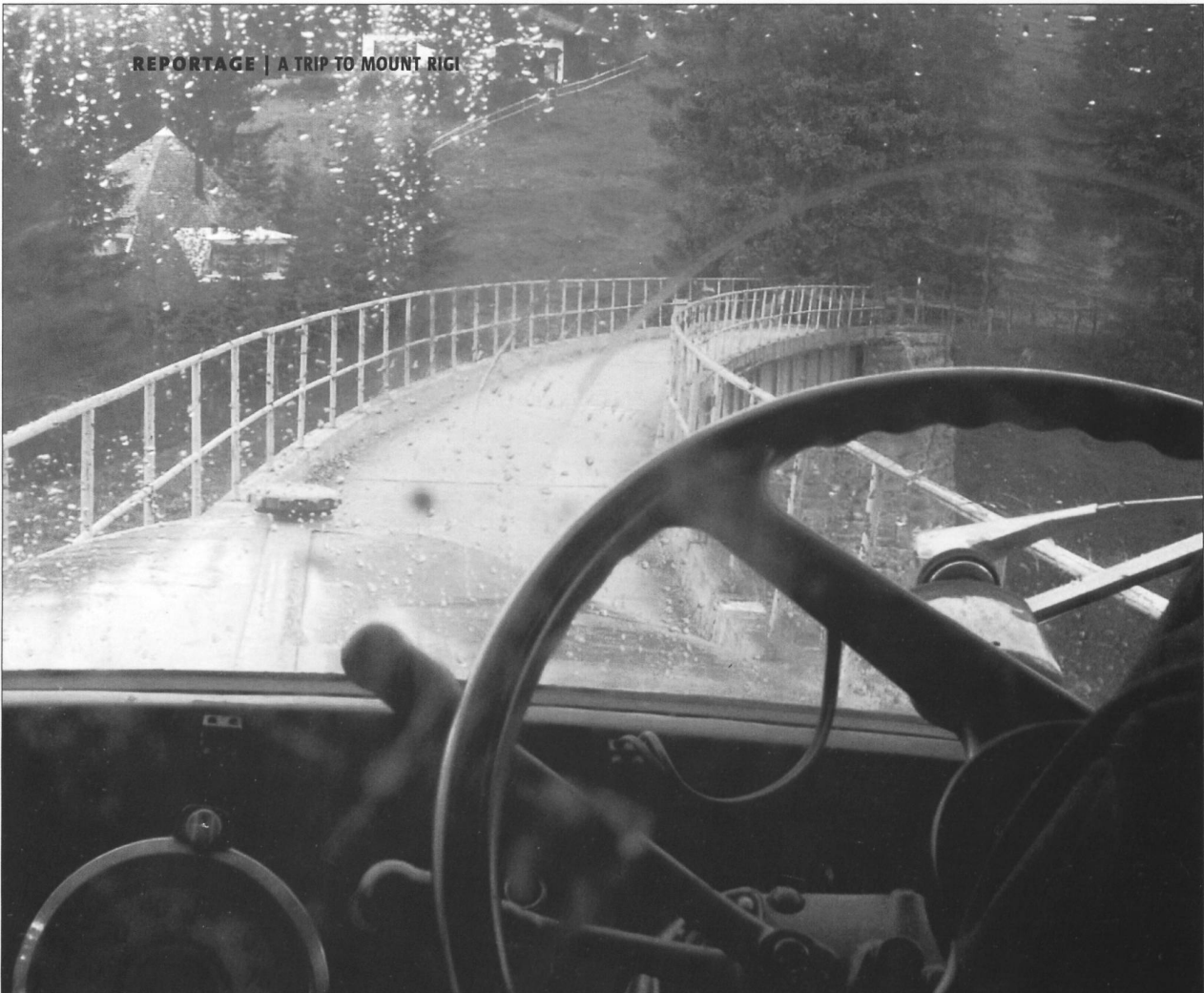
Massarbeit von Vater und Sohn Baggenstos auf dem Viadukt von Unterstetten. Die Fahrerin ist nur 5 Zentimeter breiter als ihr Saurer. Bild: Beat Winterflood
