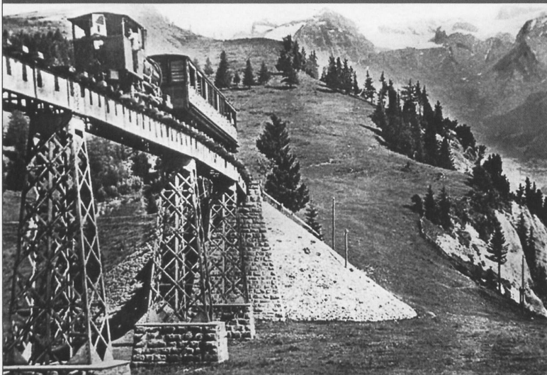
Heute Fahr- und Wanderweg: Die Rigi-Scheidegg-Bahn auf dem Eisenviadukt Unterstetten. Bild: Fotoarchiv Baggenstos
