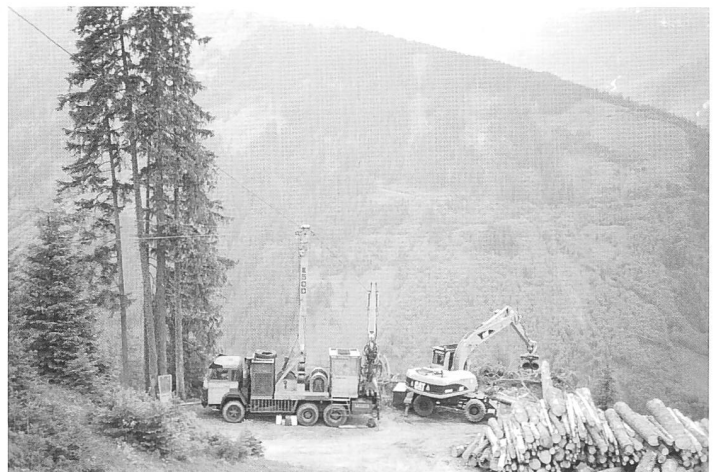
Bei der Holzbringung Gschwandtner steht dieser D330F 6x4 als Mobilseilkran in luftiger Höhe im Einsatz
