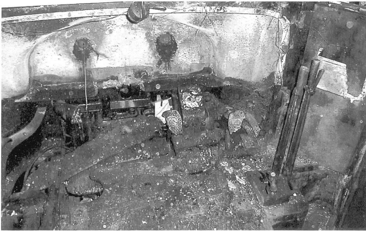
Der komplett zerstörte Führerstand
