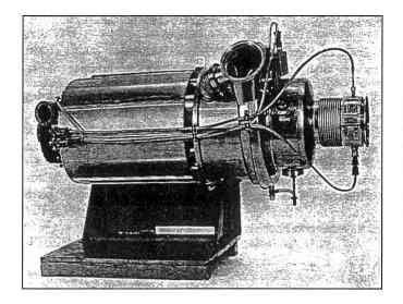
Flugzeughilfs-Aggregat, Gasturbine GT 15 ganz rechts, Gleichstromgenerator in Mitte und Gebläse G 15 ganz links, alles vollständig verschalt. Anschlüsse für Brennstoff, Gleichstrom, Steuerung, Feuerwarnung und –löschung zusammengefasst auf dem gebläseseitigen Anschlusspant. Gesamtlänge 1100 mm, Gesamtgewicht 57 kg mit Generator GE 2 CM 82 F3 von 30 kg Eigengewicht.
