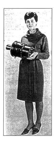
Kleine Abmessungen, geringes Gewicht, vollautomatisches Anlassverfahren, einfache Drehzahlund Leistungsregulierung kennzeichneten die als Einwellenmaschine ausgelegte SAURER Kleingasturbine GT 15. Sie sollte mit Vorteil dort eingesetzt werden, wo kleinster Raumbedarf und minimalstes Gewicht ausschlaggebend ist, also als Antrieb für Hilfsaggregate aller Art, z.B. Generatoren, Klimageräte und Pumpen.
