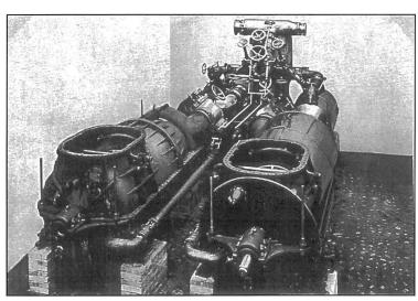
Erste Schiffsdampfturbine von BBC
