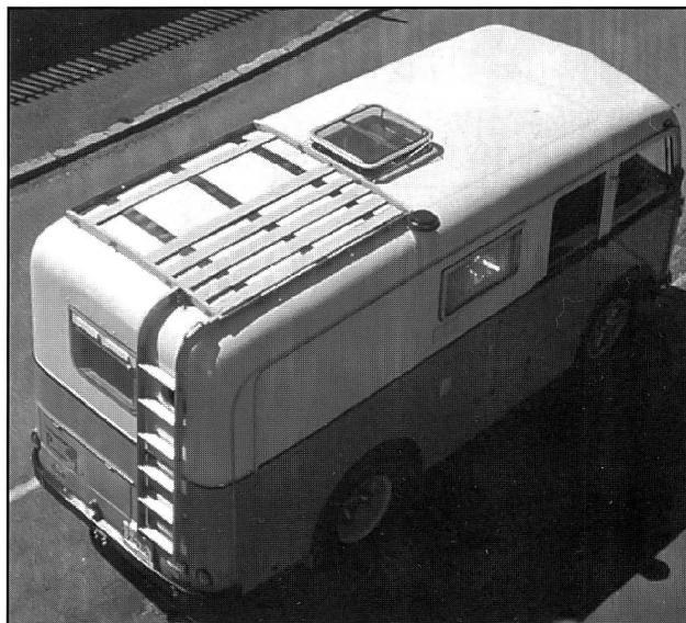
1976 wurde der Wagen an den Vorbesitzer Herrn Burkhardt aus Basel verkauft, welcher ihn zum Camper umbaute. Die Zwischenwand von der Doppelkabine zur Werkstatt wurde herausgetrennt und die einseitig angeschlagene Hecktür wurde zugeschweisst (leider). Der Grundausbau erfolgte durch den Vorbesitzer.
