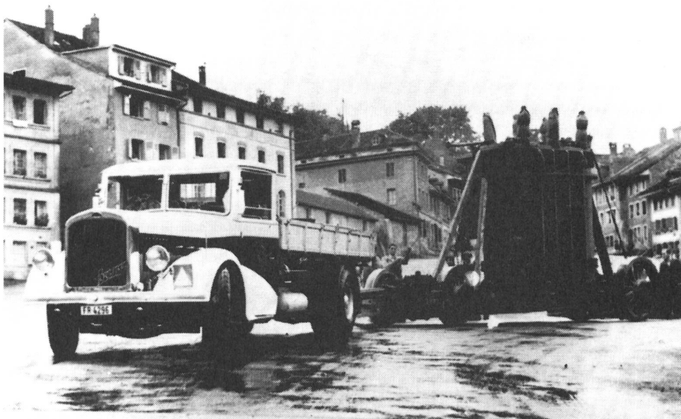
Bild 9: als Kipper + Holzrädertieflader mit Elektro-Transformer
