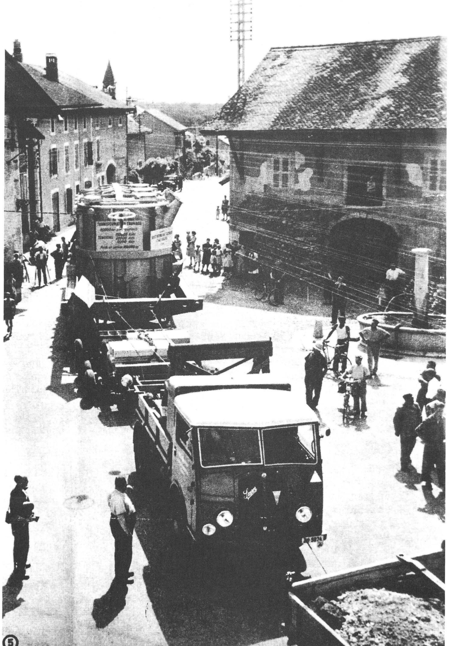
gewichtige Fuhrzeuge, und ein Lastwagen wirkt rückwärts als Bremse. Der Strassentransport geht auf diese Weise bis Lyon. Von dort trägt die Rhône das Riesengewicht bis Marseille, wo neuerdings umgeladen wird. Die Traktoren fahren bis dorthin, um ebenfalls aufs Schiff verladen zu werden. Sie werden von Algier aus, auf gleiche Weise wie bis Lyon, das Monstrum nach Arba bringen.
