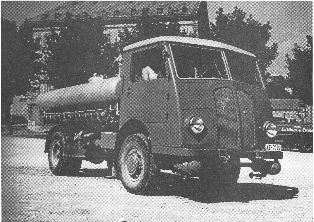
Saurer 5CM Sprengwagen , Abgeliefert am 9.8.52. an Ville de La Chaux-de-Fonds , Chassis Nr. 20500/6 Motor Typ CT2D , Motor Nr. 84197
