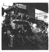
Motorenmontage: Die sorgfältige Montage der Motoren und die richtige Einstellung sind für deren einwandfreien Betrieb unerlässlich.
