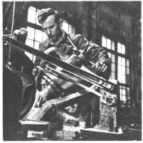
Schleismaschine für Zahnräder: Die grösste Genauigkeit und feinste Bearbeitung ist gerade gut genug für das einwandfreie Arbeiten der Zahnräder.
