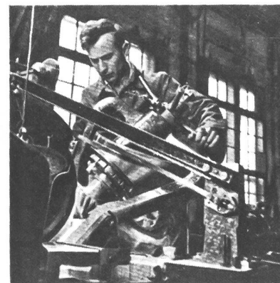
Schleifmaschine für Zahnräder: Die grösste Genauigkeit und feinste Bearbeitung ist gerade gut genug für das einwandfreie Arbeiten der Zahnräder.
