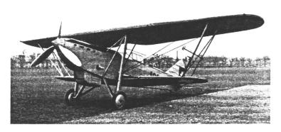
Konstrukteur: K+W, Thun. Werk: K+W, Thun. Baujahr: 1936. Material: Leichtmetall, Stahl. Holz, Stoff. Verwendung: Mehrzweck. Länge: 9,54 m. Höhe: 3,15 m. Spannweite: 13,08 m. Inhalt: 32 m². Leer: 2000 kg. Zuladung: 1120 kg. Total: 3120 kg. Max.-Geschwindigkeit: 330 km/h. Steigzeit: 1000 m: 2°; 2000 m: 4.1°; 3000 m: 6,25°; 4000 m: 8,5°; 5000 m: 11,75°. Gipfelhöhe: 10 000 m. 1 S.L.M.-Saurer-Motor, Lizenz Hispano-Suiza zu 860 PS. 12 Zyl. (1848).
