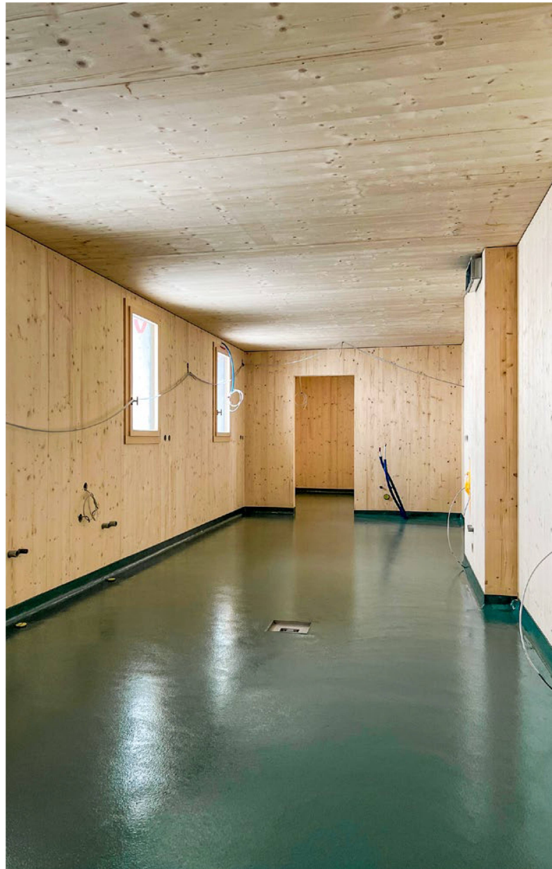
Küchenraum, bereit zur Montage. Bild: Werkgruppe agw Bern.
