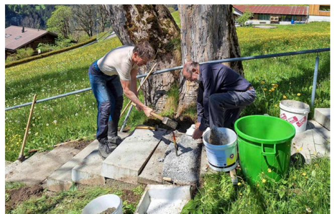
Reparatur der Zugangstreppe zum Chalet Teufi. Bild: Emil Brünger.
