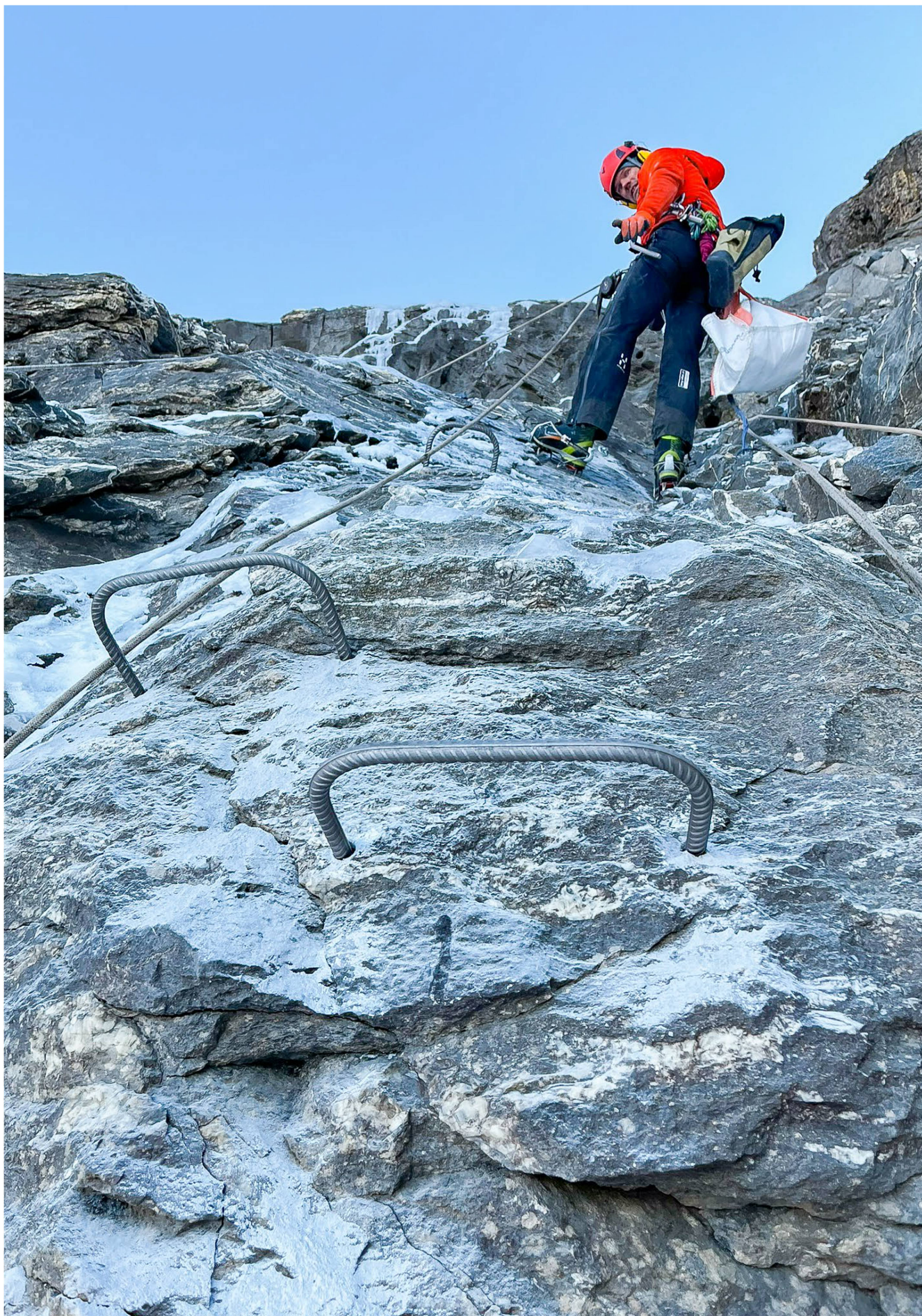
Sanierung Gamchilücke. Bild: H. Christen.
