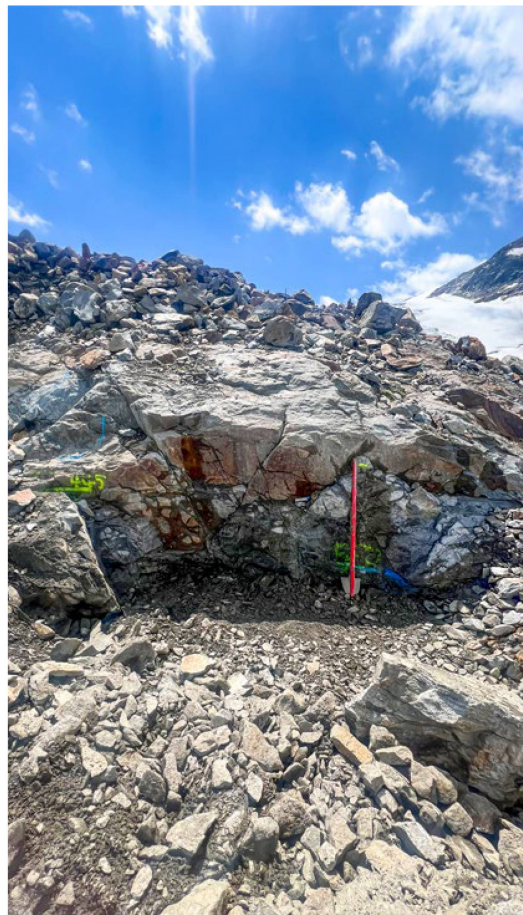
Aushub für Tropfkörper-Tank für die Grauwasseranlage. Bild: Joris Rothenbühler, Werkgruppe agw Bern.
