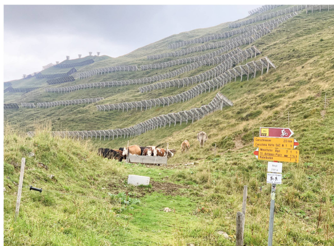
Die Lawinengefahren in den Bergen wurden thematisiert. Hier sieht man die Schutzverbauungen am Chüenihorn.
