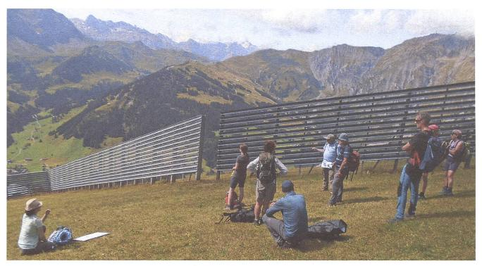
Lawinenschutzwand, die der Verfrachtung von Schnee dient: Durch die Öffnungen strömt Wind, sodass der Schnee an Stellen geblasen wird, wo er nicht zur Lawine werden kann.
