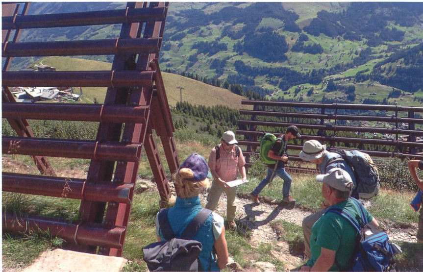
Jean-Jacques erklärt den Aufbau und die Funktion einer Schneebrücke aus Stahl. Dank dem Rost ist diese in der Landschaft weniger auffällig.
