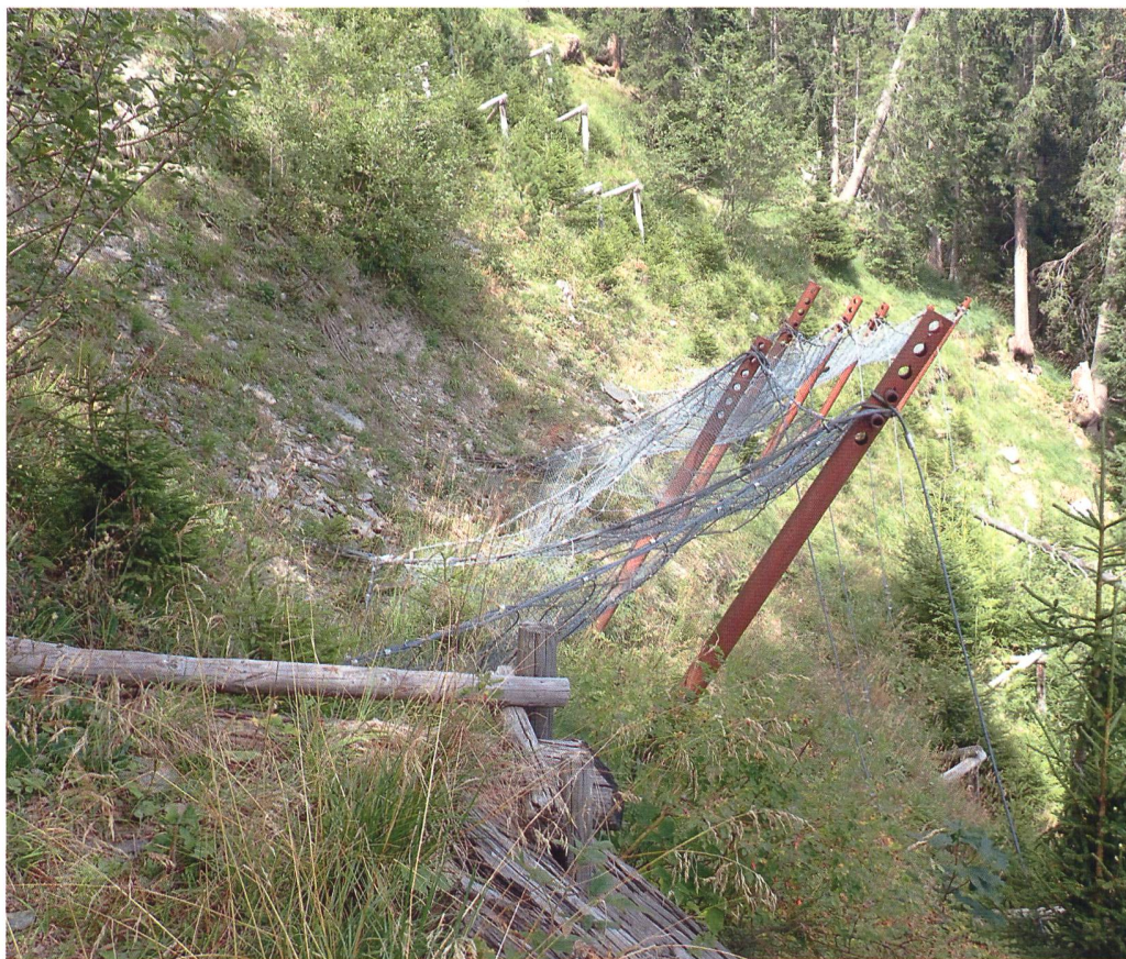
Im Vordergrund eines der neueren Schneenetze und im Hintergrund die sogenannten Ogiböcke aus Kastanienholz. Diese schützen Jungwuchs vor abrutschenden Schneemassen.
