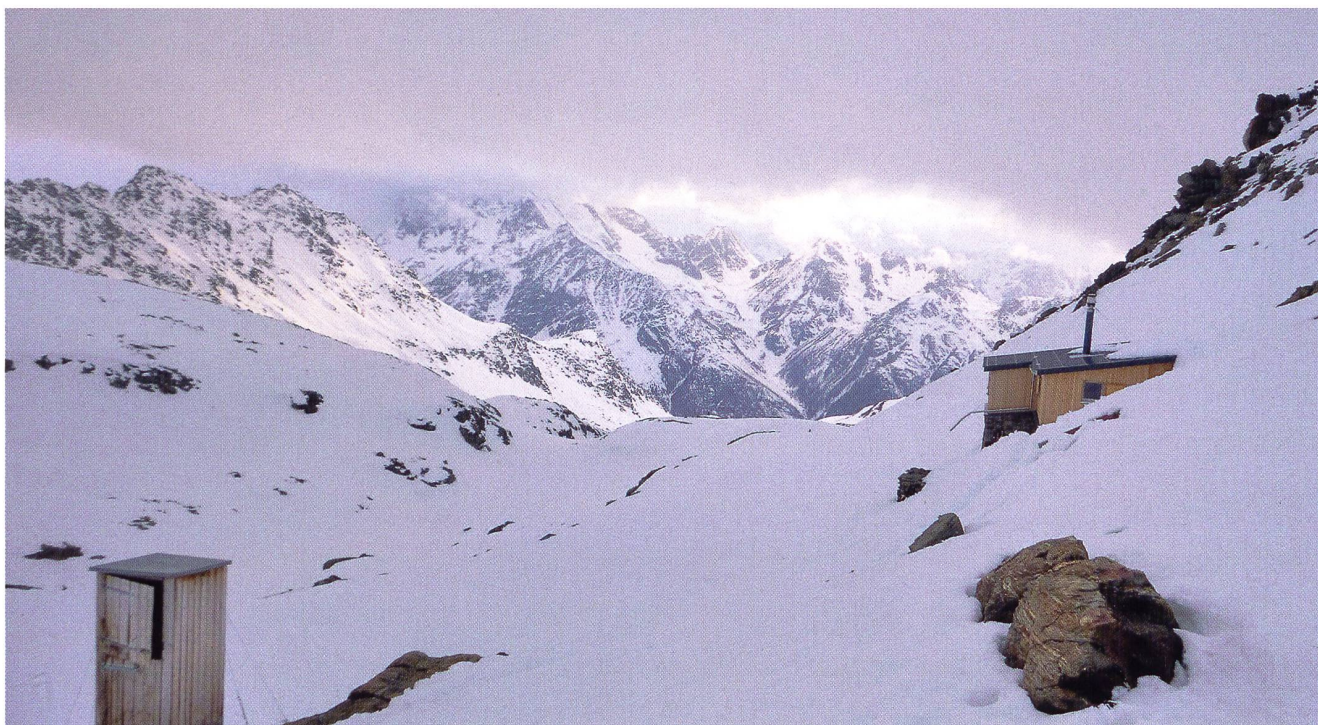
Die Fletschhornhütte ist seit Herbst 2011 um eine Etage höher.
