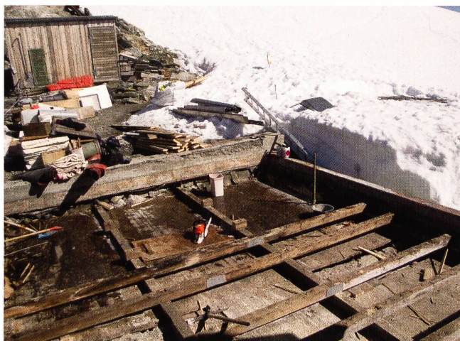
Abbruch der alten Kellerdecke durch die Hüttenwerker.
