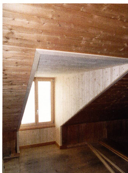
Die neue Lukarne in Zimmer «Lötschenlücke». Das neue Fenster ermöglicht in Zukunft die gefahrlose Evakuierung im Notfall.
