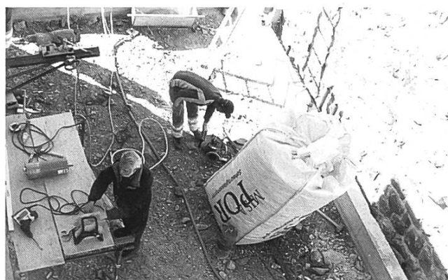
In diese «Lücke» kommen die Holzelemente.
