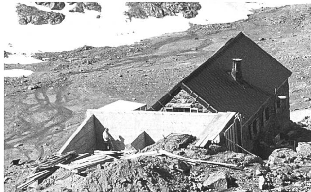
Rückwand des Ebenhöchs mit Flügelmauer.
