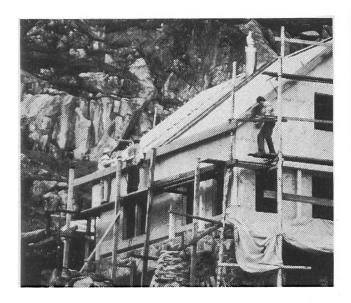
Kosten und weil gut vermauerbarer Naturstein am Ort nur ungenügend vorhanden war, fiel der Entscheid für diese leicht zu transportierende Bauweise. Die Fassaden aus sägeroher Holzschalung und ein Kupferblechdach mit integrierter Blitzschutzanlage schützen den Bau vor dem rauhen Bergwetter.
