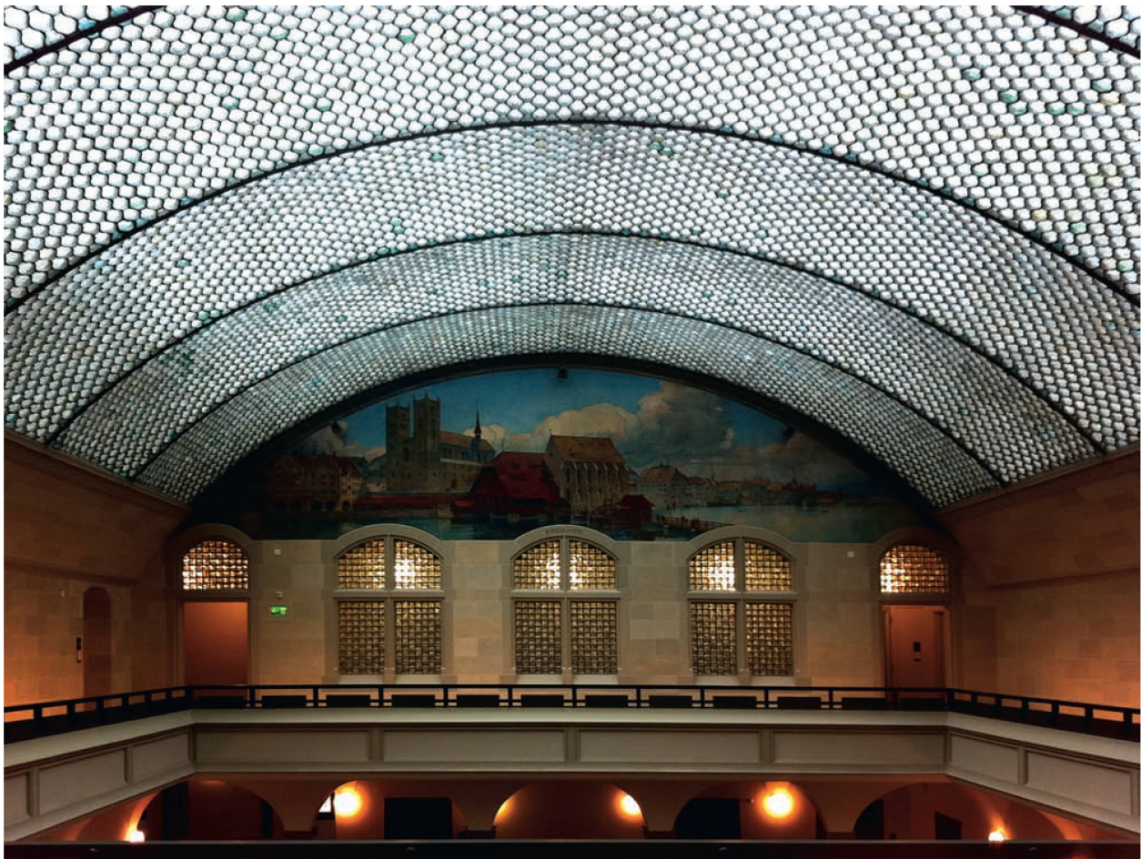
Vue de la voûte et des panneaux en briques de verre soufflé Falconnier de l'Hôtel de Ville de Zurich par Gustav Gull, 1898-1900 (photo Aline Jeandrevin, 2015).
