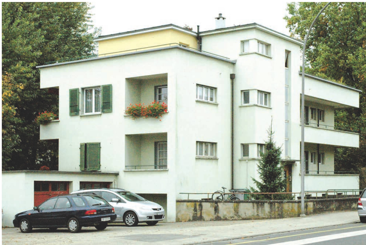
Horace Decoppet, immeuble d'habitation « Les Platanes », avenue des Quatre-Marronniers 2, 1935 (photo Dave Lüthi, 2015).
