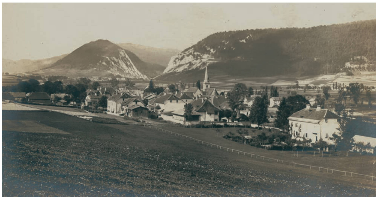
Vue de Môtiers dans le Val-de-Travers, patrie de la « montre chinoise », avec la maison familiale des Loup au premier plan, fin XIX e siècle.
