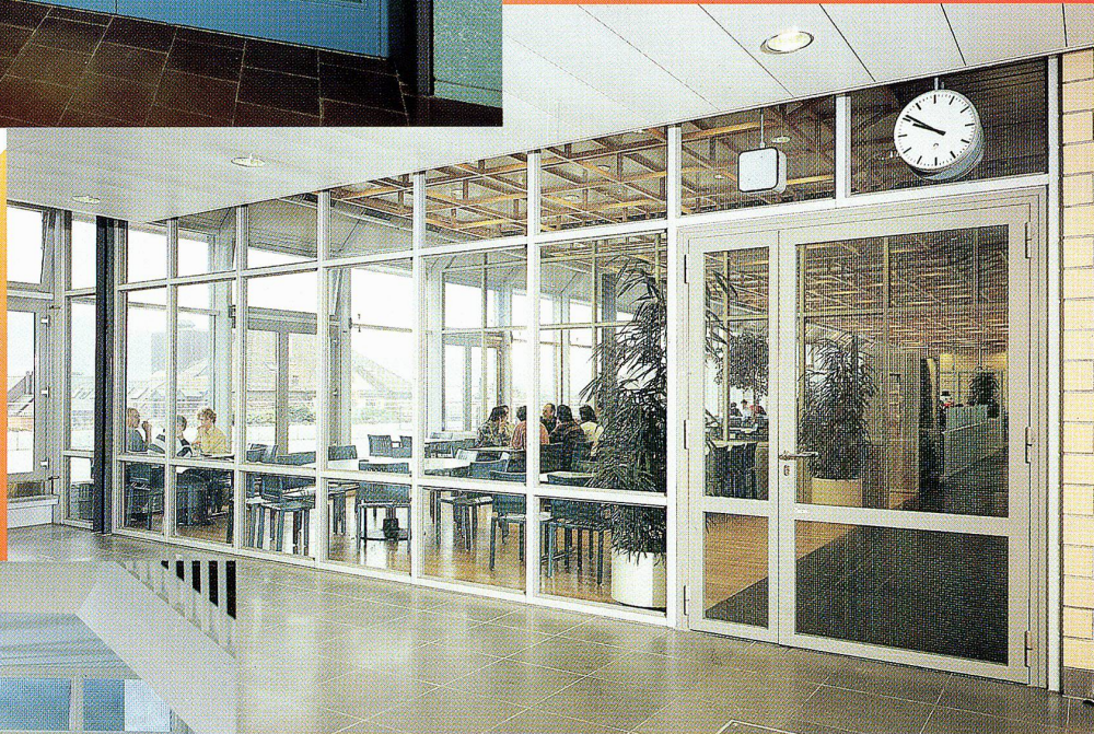
Brandschutztüre mit Elektroantrieb ▲
