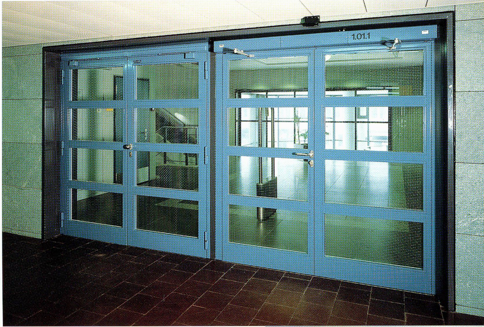
Brandschutztüre mit Elektroantrieb ▲
