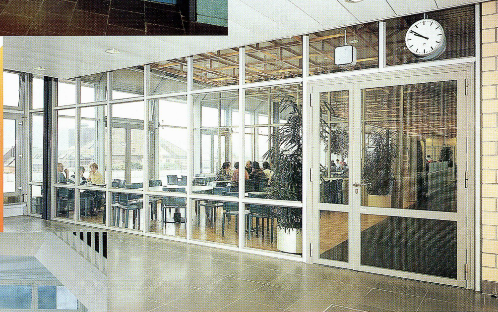
Brandschutztüre mit Elektroantrieb ▲
