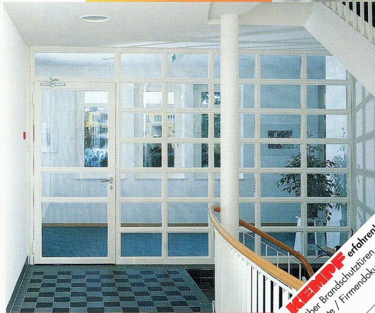
Brandschutzabschlüsse im Altersheim Dietikon ▲
