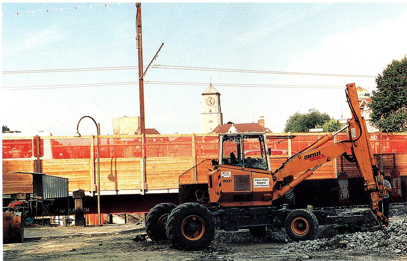
ohne Unterbruch zirkulieren zu lassen. Dafür wurde im Juni eine vormontierte, vier Meter breite Holzbrücke westlich der alten Brücke eingesetzt.
