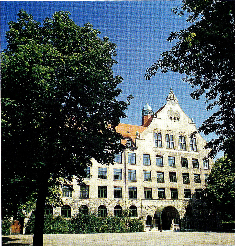
Das Hadwigschulhaus – eine altherwürdige St. Galler Bildungsstätte erstrahlt im neuen Glanz.
